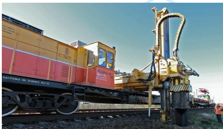
Рис. 1. Вибропогружение фундаментов опор контактной сети агрегатом АВФ
