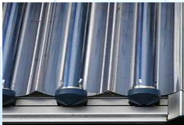
3- rasm. Vakuumli quyosh kollektorining umumiy ko'rinishi va quvurlarining joylashuvi.
