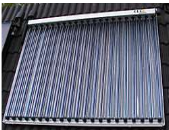
3- rasm. Vakuumli quyosh kollektorining umumiy ko'rinishi va quvurlarining joylashuvi.
