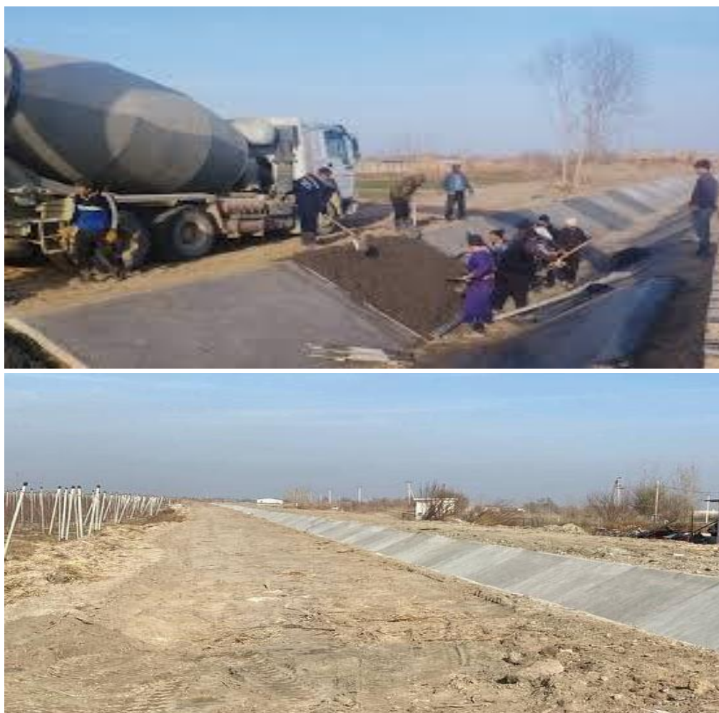
1-rasm Kanallarni betonlash jarayoni.
