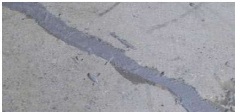
рис. 2. Смесь для ремонта трещин быть наполненным.
