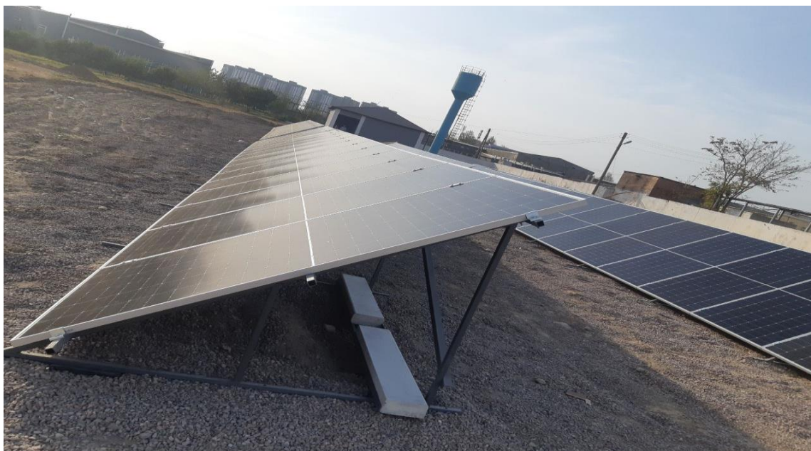
1-расм ТДТУ ОФ “Металлургия ва кимёвий технологиялар” факултетиди ўрнатилган 50 кВт қувватга эга булган қуёш панелари
