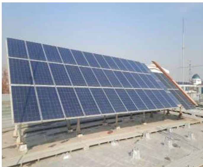
1-rasm. O‘rnatilgan quvvati 9 kVt quyosh fotoelektr stansiyasi tashkiliy qurilmalari
