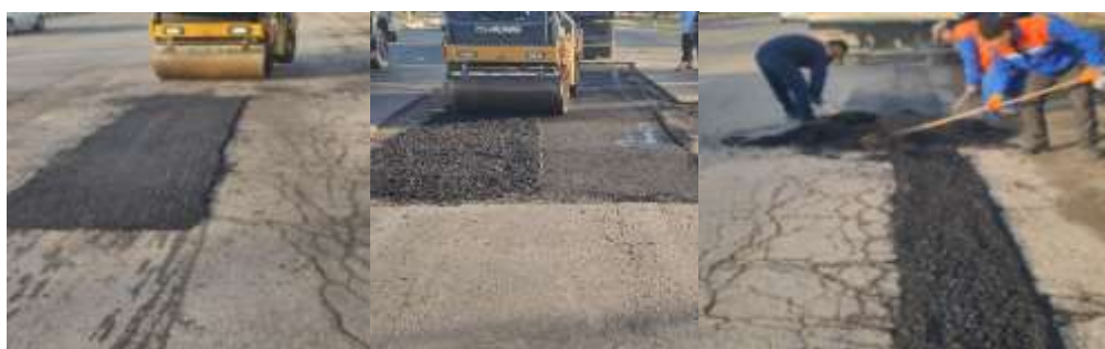
4-rasm Yoriqlarni ta'mirlash
