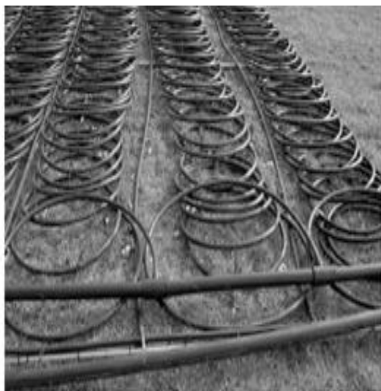
Рис. 3. Схема размещения коллектора для горизонтальных геотермальных тепловых насосов
