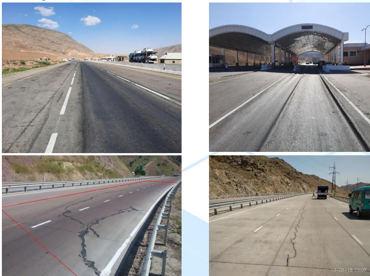
Рис. 1. Результаты негативного воздействия движения грузовых АТС с перегрузом на автомобильных дорогах Республики Узбекистан
